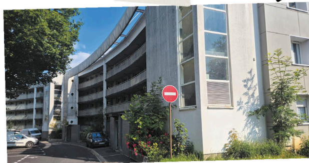
LA RÉSIDENCE PUVLIS DE CHAVANNES
