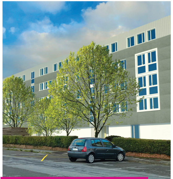
Le nouveau revêtement et l'isolation des façades changeront l'aspect extérieur de la résidence.
