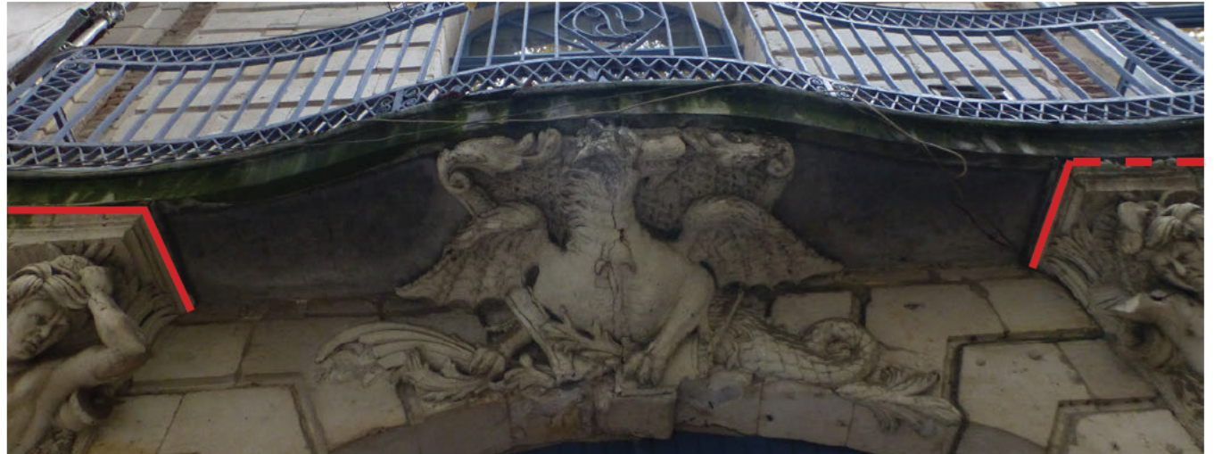
En rouge : protection en zinc altérée En pointillé rouge : absence de protection en zinc, entrainant une dégradation du décors
