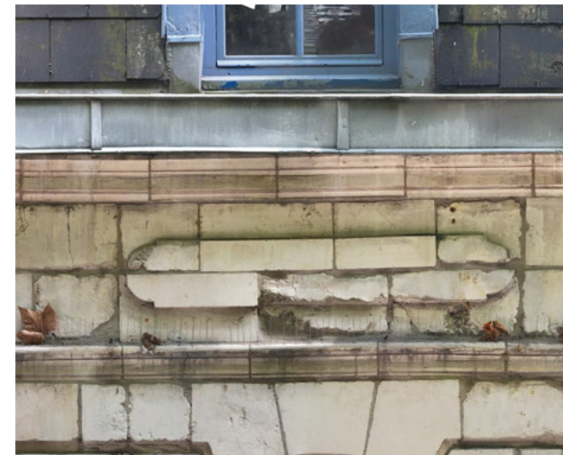
Cartouche altéré, pierres présentant des épaufrures, colonisation biologique de la partie supérieure.
