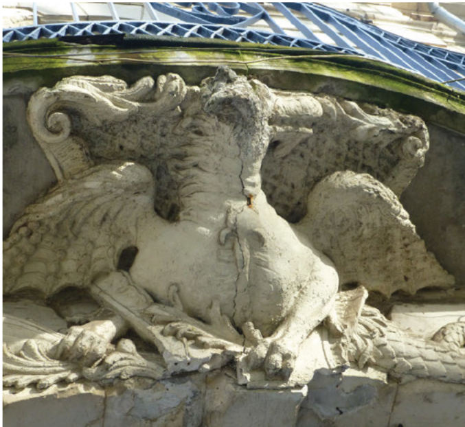
Colonisation biologique du nez de la dalle du balcon. Importante fissure sur la sculpture de dragon
