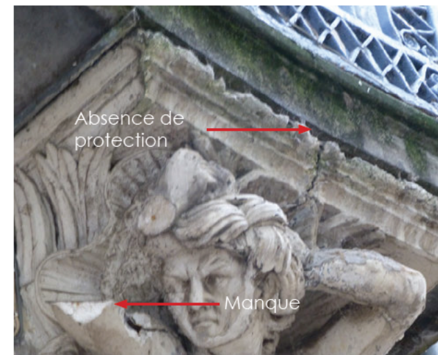
Présence de fissures, perte de matière, éléments métalliques oxydés, absence de recouvrement de la feuille de zinc.
