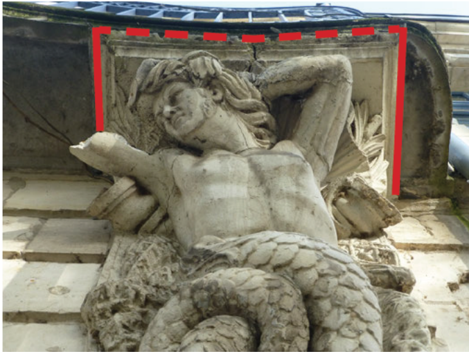
En pointillé rouge : absence de protection en zinc entrainant une dégradation du décors
