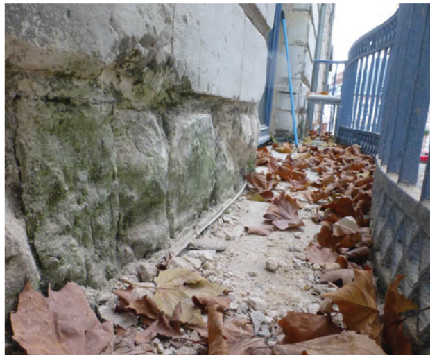
Assises basses du balcon dégradées dues aux rejaillissements des eaux de pluies
