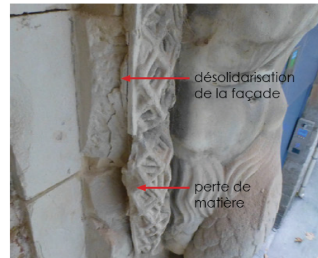
Maçonnerie altérée, impactant sur la stabilité des sculptures. perte de matière
