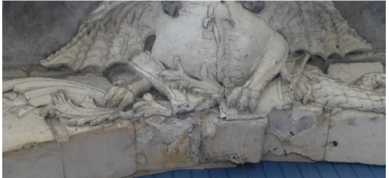
Pulvérulence des pierres formant la clef de l'arc de l'ouverture principale. La clef d'arc glisse, présence de ragréages anciens
