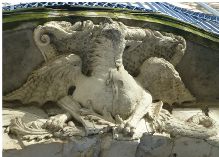
Clef en forme de dragon (sculpture en plâtre) fixé à l'aide d'attaches métalliques
